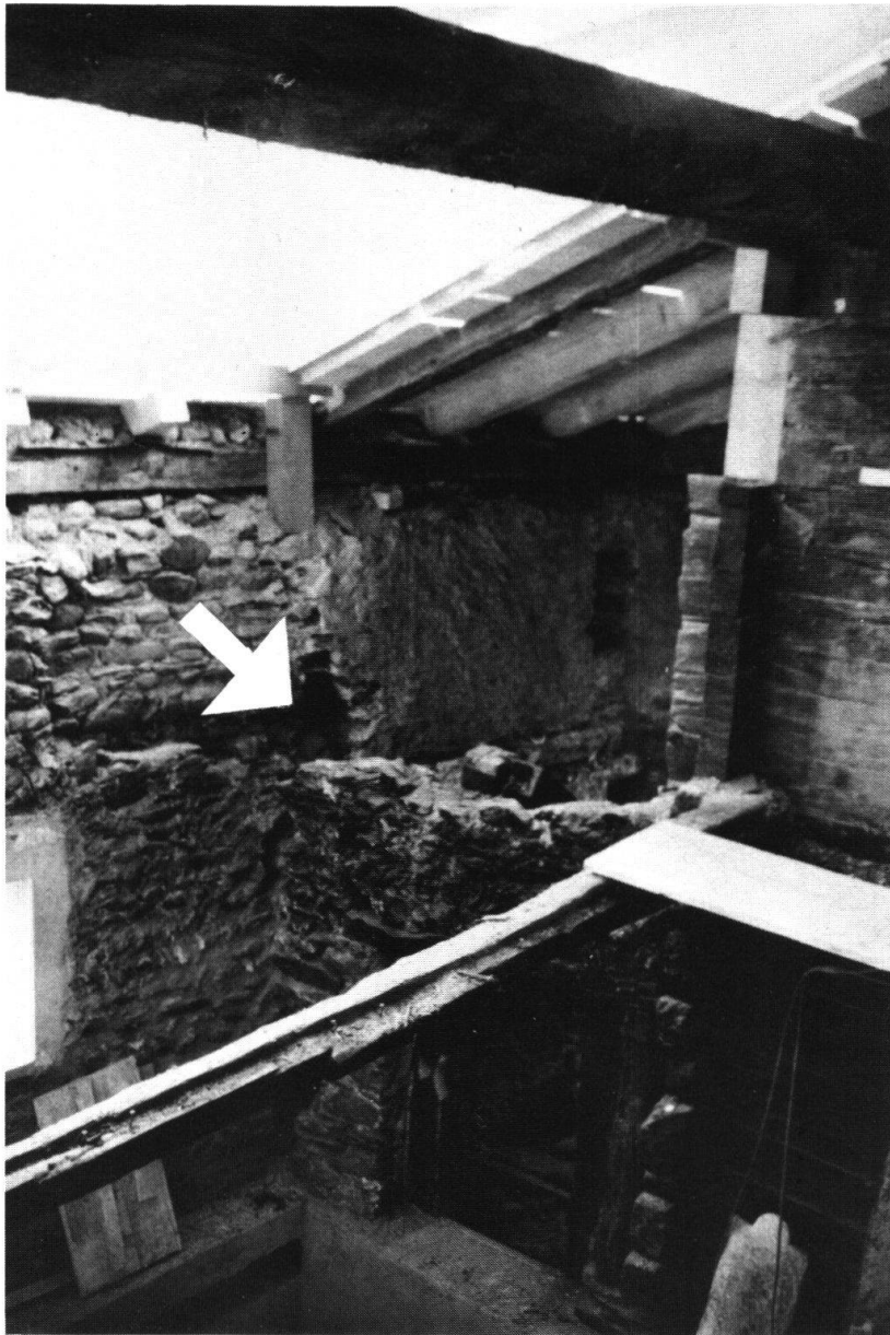
Abb. 3 Fundstelle in der südwestlichen Hauswand.
