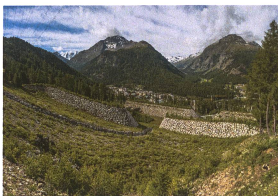
Pontresina, GR: Weil der Permafrost am Schafberg oberhalb von Pontresina auftaut, ist die Wahrscheinlichkeit niedrigerer Murgänge stark gestiegen. Dies machte den Bau hoher Dämme und eines riesigen Auffangbeckens notwendig. Seit 2003 schützen diese Kunstbauten die Ortschaft.
