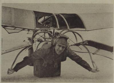
Fliegen aus eigener Kraft: Rudolf Abbühl mit seinem selbstkonstruierten Muskelkraft-Flugzeug. Mit den Armen bewegt der Pilot zwei Schwingflügel, welche den Auftrieb liefern sollen Bild: Varrone
