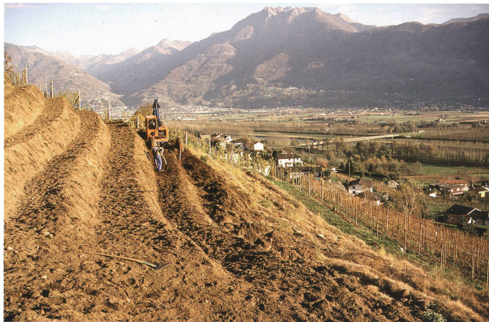
Fig. 5 – Scavatore idraulico, impiegato nella costruzione dei terrazzi e scasso del terreno (foto: Mirto Ferretti).
