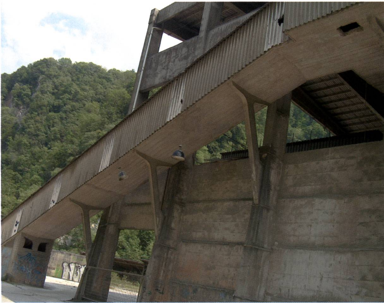
Fig. 3 – Dettaglio della rampa che sosteneva il nastro trasportatore del materiale estratto dalla cava e destinato ai punti di lavorazione.
