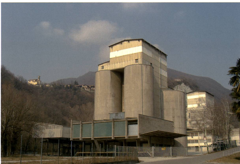
Fig. 4 – I silos di stoccaggio del cemento.
