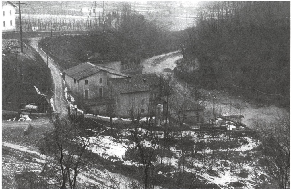
Fig. 3 – Panoramica del Mulino del Ghitello durante i lavori di incanalamento della Breggia agli inizi degli anni '60.
