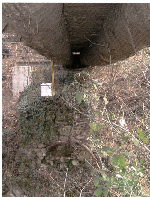
Fig. 4 Il ponte del Farügin, particolare della spalla sinistra in pietra naturale del vecchio ponte e la nuova spalla in cemento che sostiene l'attuale ponte in legno costruito nel 2000. La scatola bianca appesa sotto il ponte è l'alloggiamento per un termometro.
