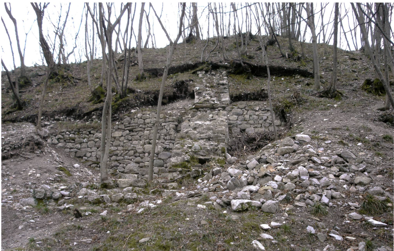
Fig. 3 – Resti di muri sulla parte settentrionale del perimetro fortificato.
