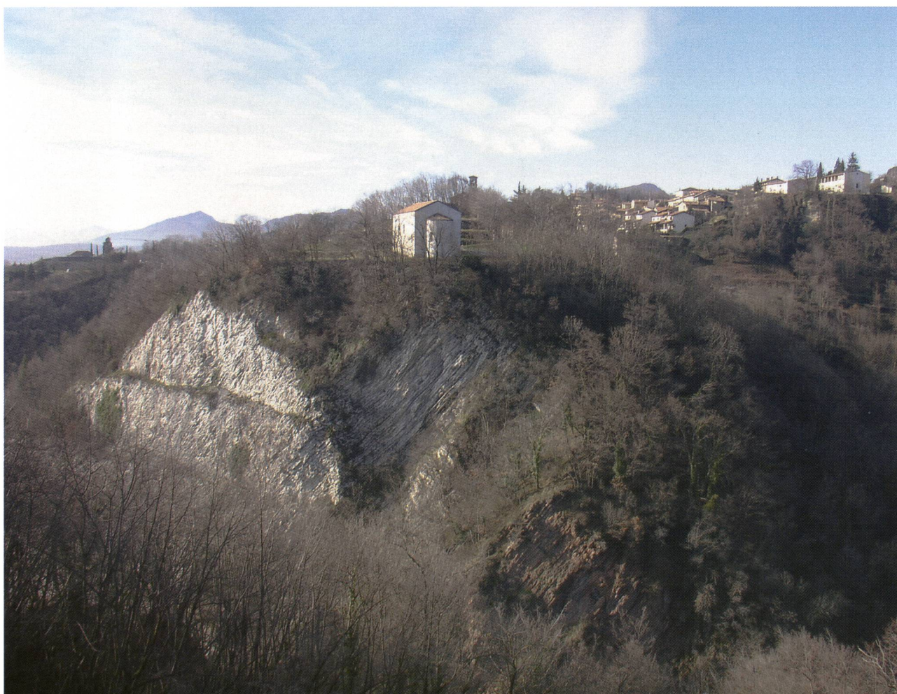
Fig. 21 – La Chiesa Rossa, 2006, il bosco ha ricolonizzato quasi completamente il fianco della gola.
