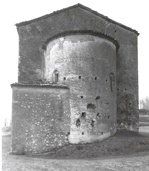
Fig. 3 – Abside e vecchia sagrestia (in seguito distrutta).
