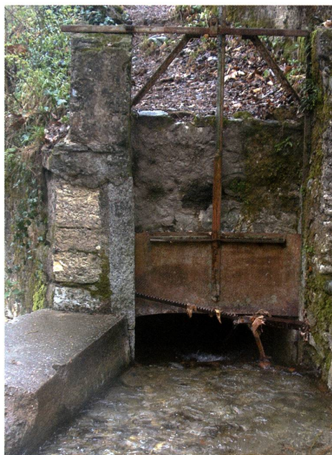
Fig. 6 – Saracinesca di un condotto di adduzione dell'acqua.
