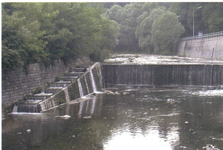
Fig. 9 (sopra) – La scala di rimonta dei pesci in vicinanza del confine italo-svizzero.
