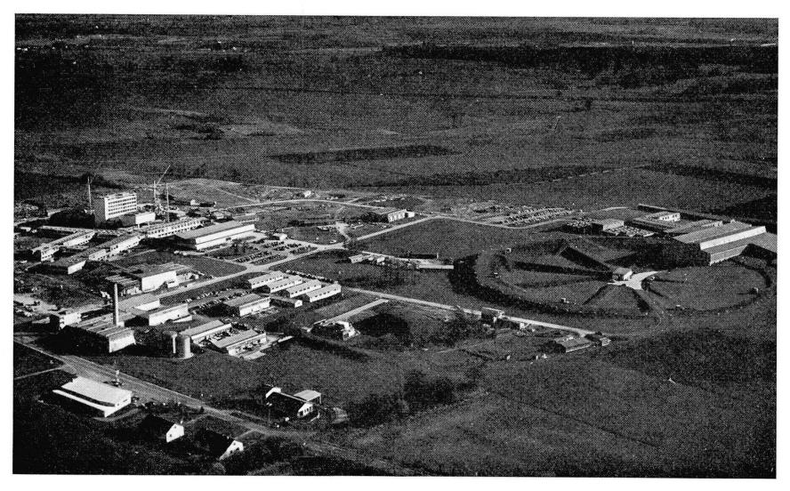
Fig. 8 Ansicht des CERN. Die Anlage für das 25-BeV-Protonsynchrotron ist rechts im Bilde sichtbar mit dem 200 m im Durchmesser messenden Beschleunigungsrohr, das sich unter dem ringförmigen Erdhügel befindet. Die acht radialen Kanäle dienen für geodätische Vermessungskontrollen. Die Experimentierhalle ist rechts oben sichtbar
