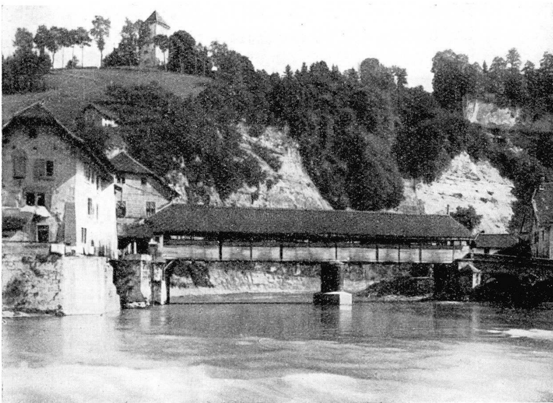
Fig. 2. Pont de Berne, vue aval
