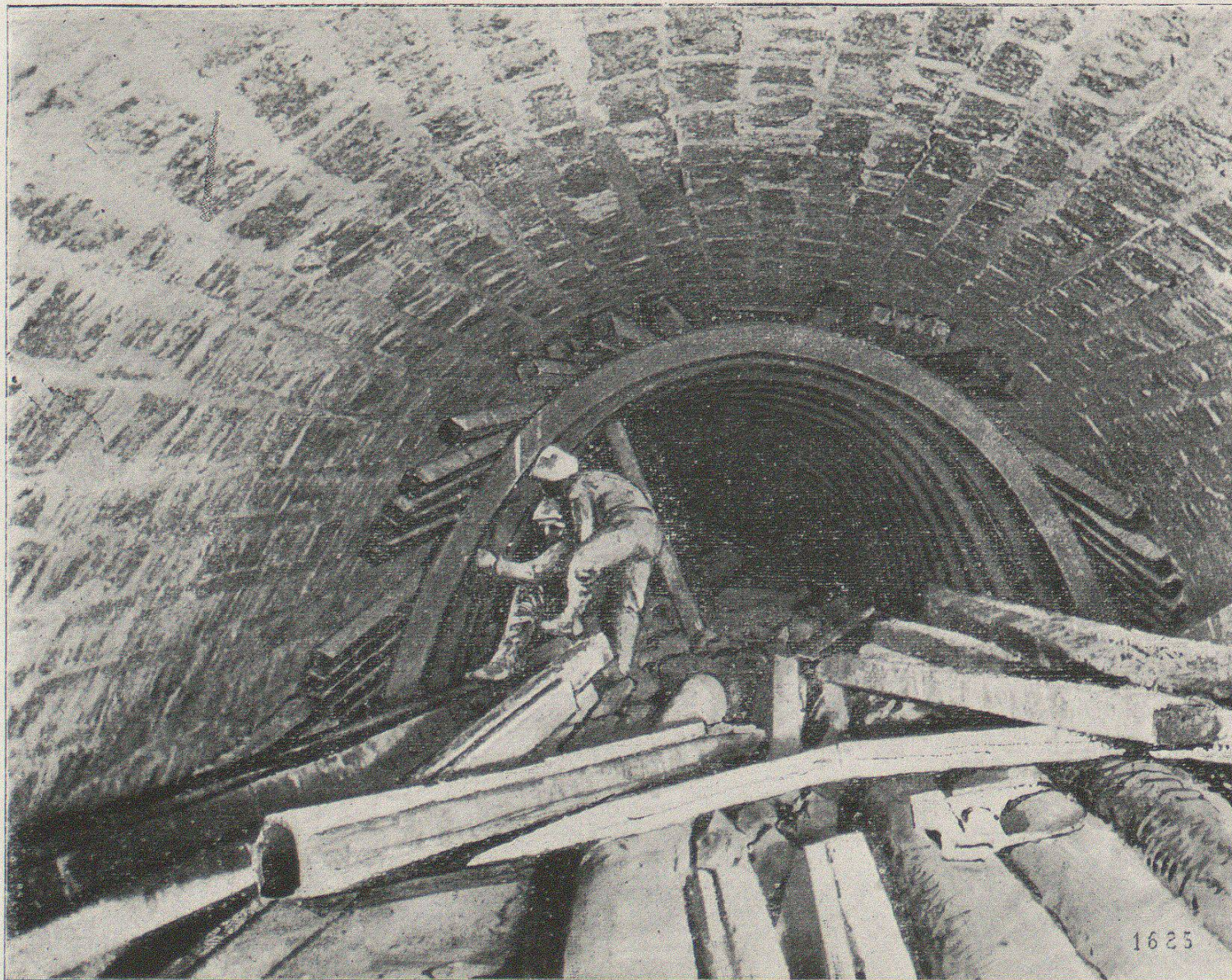
Tafel 13: Fertige Ausmauerung der First und Lehrbögen.
