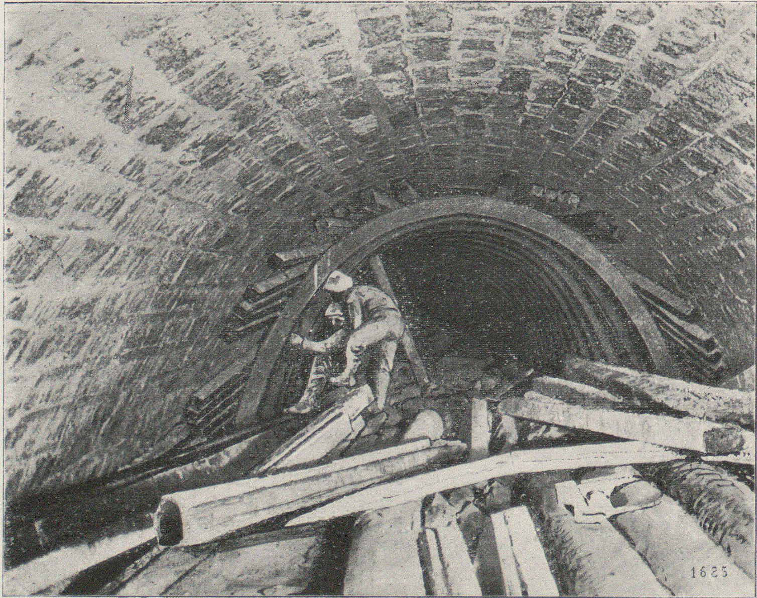
Tafel 13: Fertige Ausmauerung der First und Lehrbögen.
