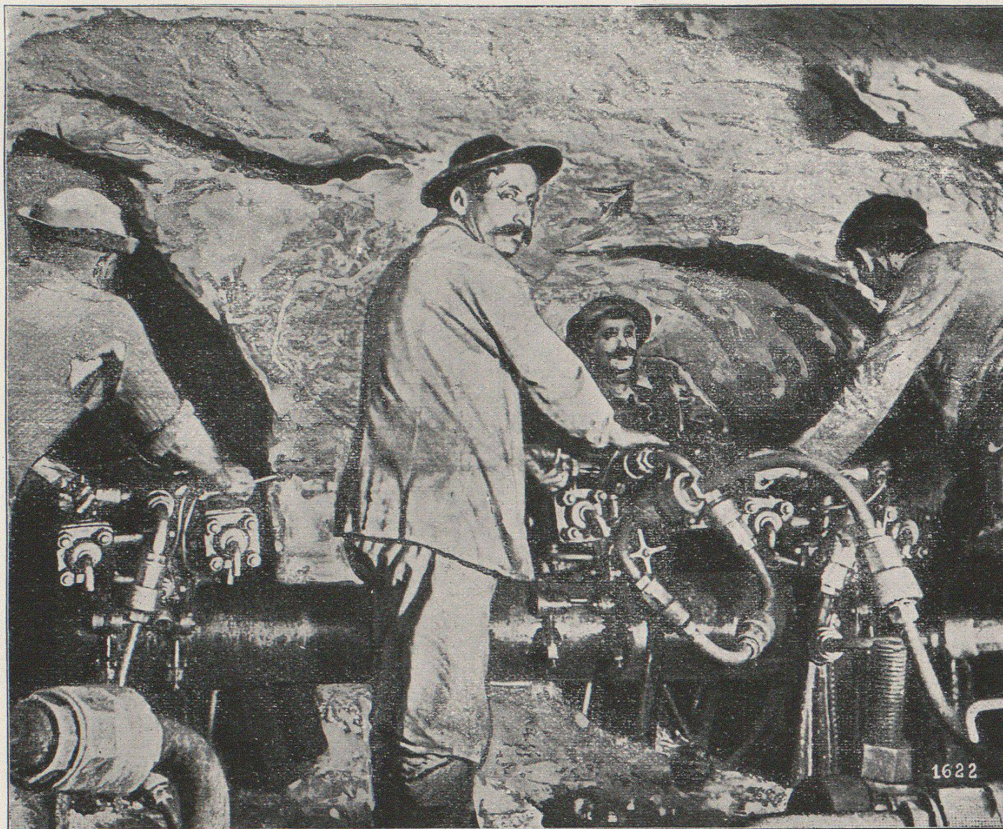
Tafel 5: Bohrmaschine Vorort.
