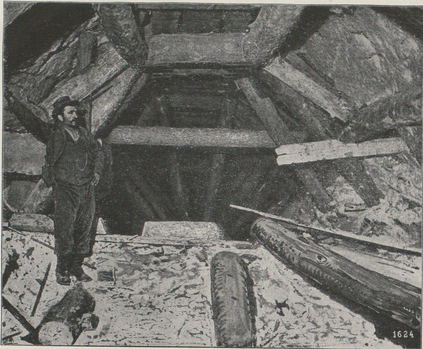
Tafel 18: Einbau im Firststollen.
