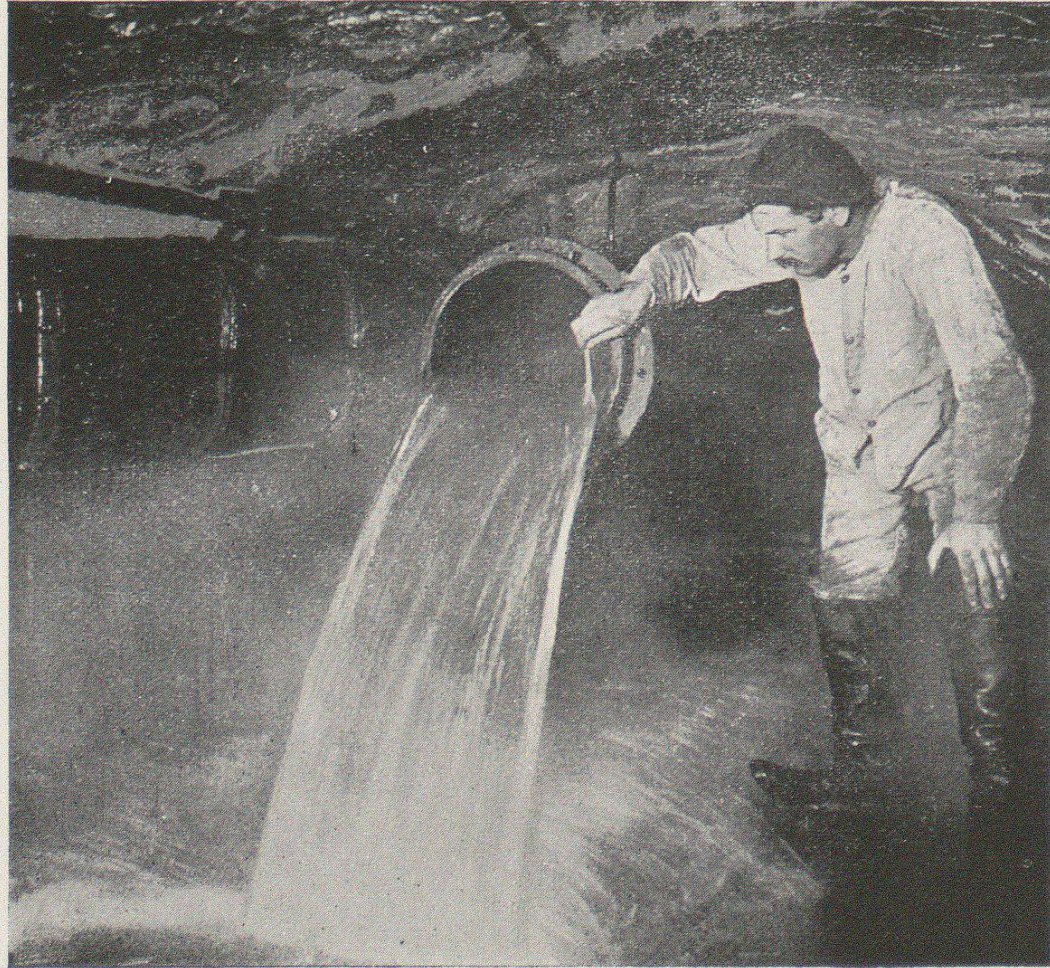
Tafel 25: Temperaturmessung des heissen Wassers a. d. Nordseite.
