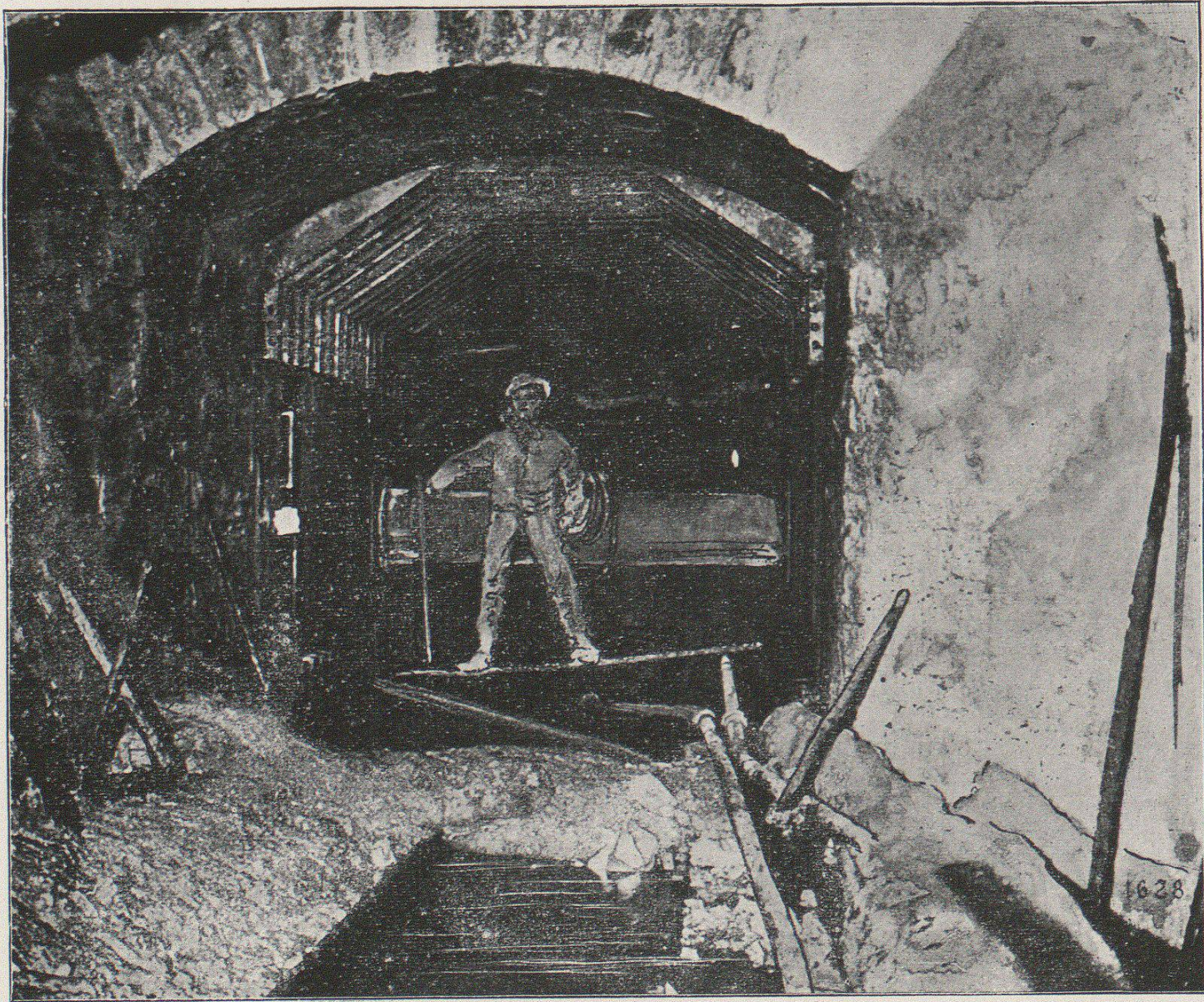
Tafel 23: Eiserner Einbau an der Druckstelle.
