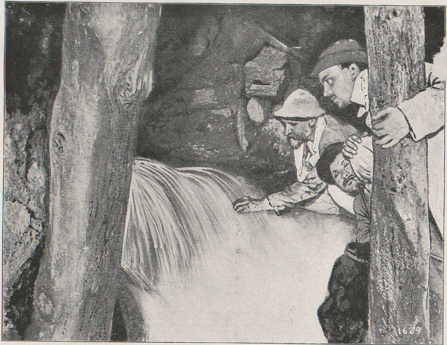
Tafel 20: Wassereinbruch auf der Südseite
