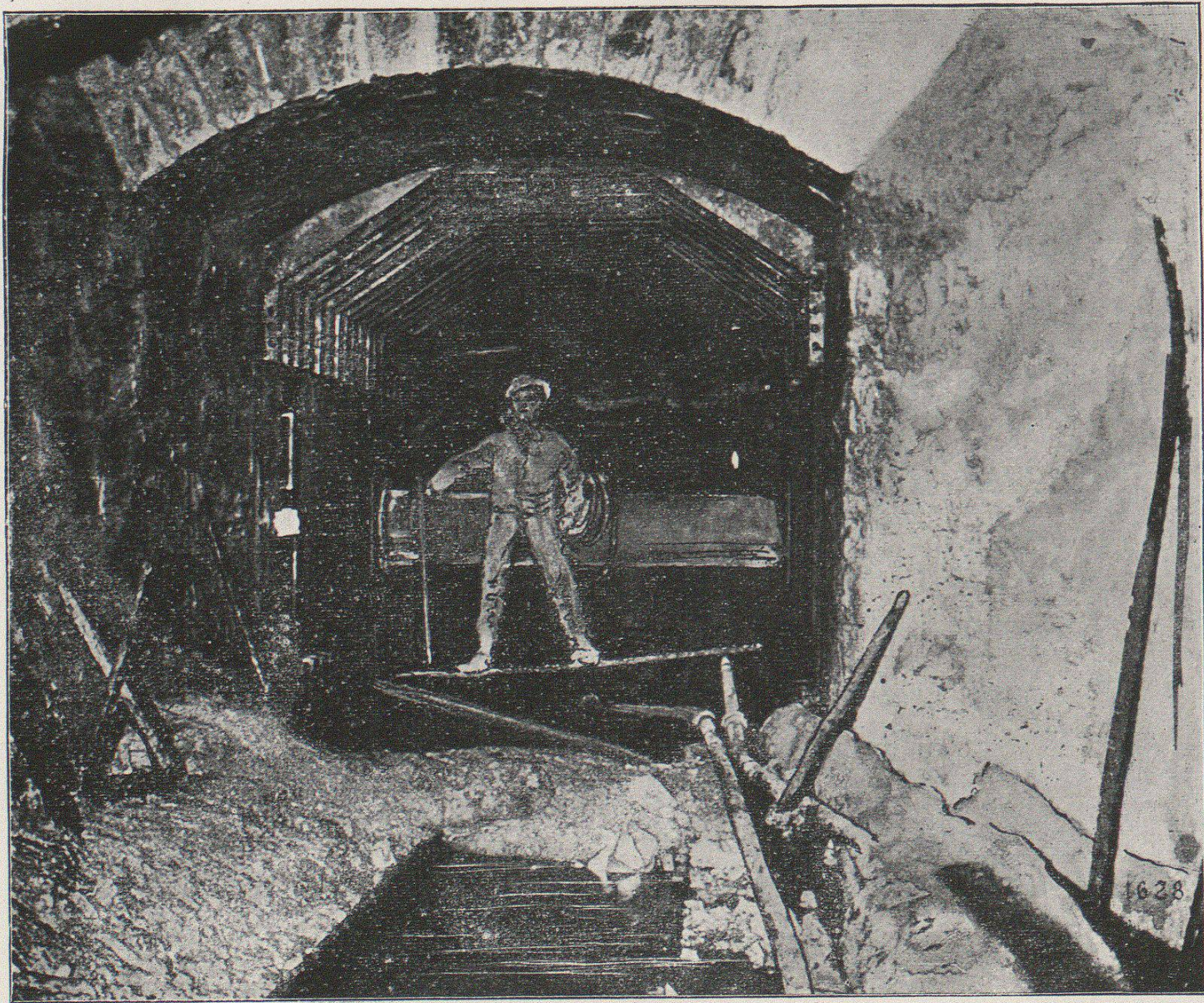
Tafel 23: Eiserner Einbau an der Druckstelle.
