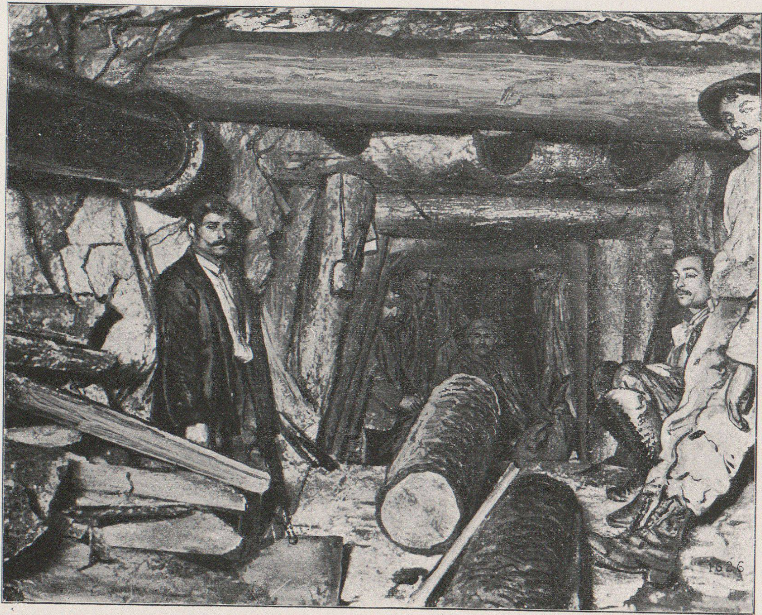
Tafel 21: Hölzerner Einbau an der Druckstelle.
