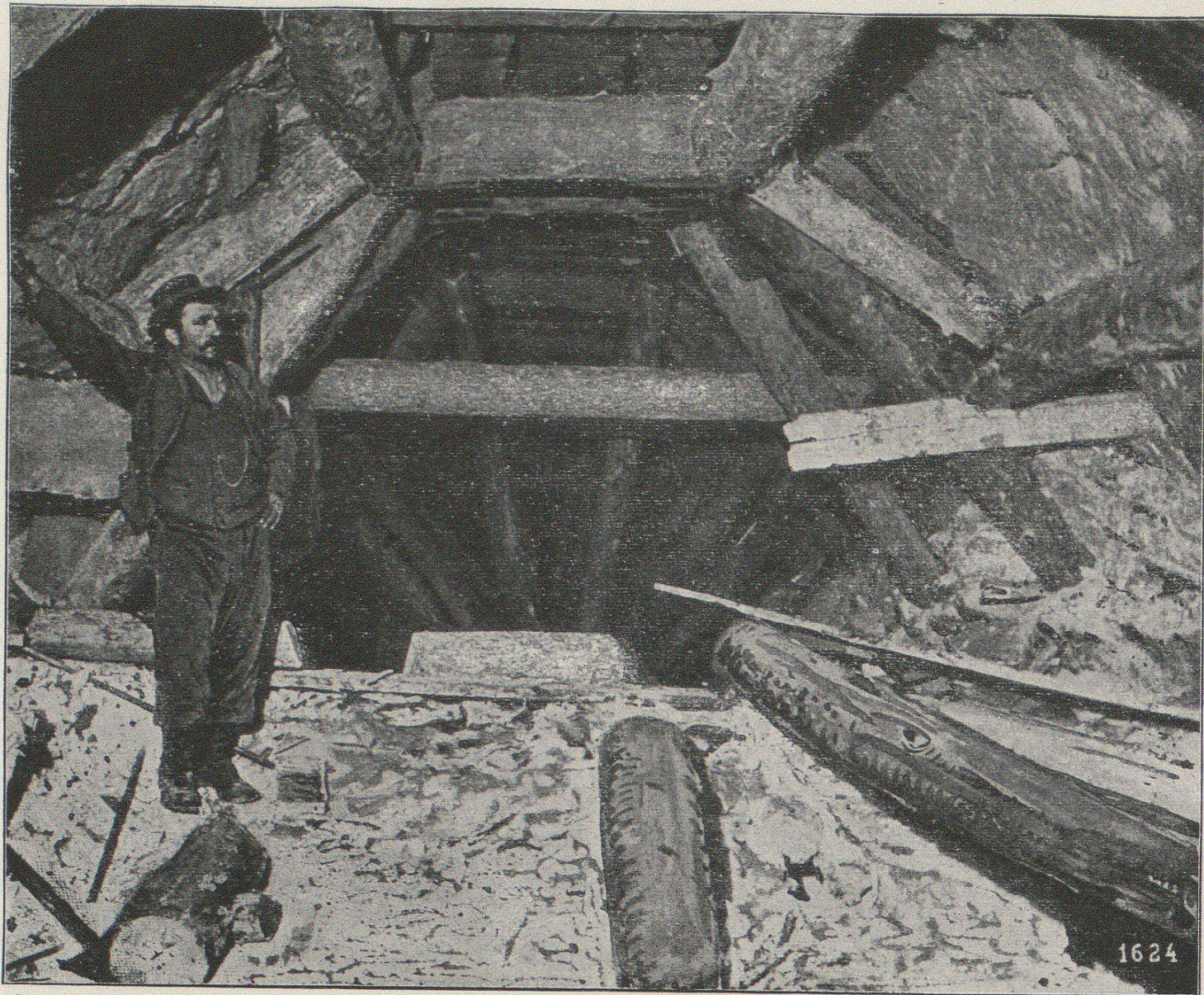
Tafel 18: Einbau im Firststollen.
