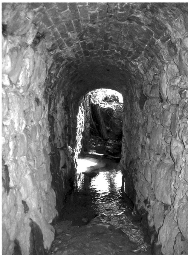
Fig. 1 – Galleria drenante g1 a Castello di Brianza (LC) (foto B. Bianchi).
