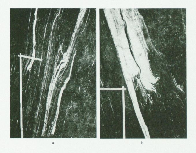
Photo 19a, b und c. Drei Aufnahmen ein und derselben Gipslage auf der Westseite des Stollens (a), der Stollenfirst (c) und der Ostseite (b). Kabelstollen, m 539.
