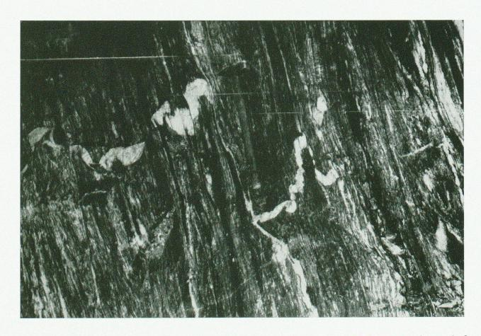
Photo 12. Subhorizontaler Aplitgang, von jüngerer, steiler, alpiner Schieferung zerrissen. Auf mehreren Bewegungsflächen findet sich ein cm-mächtiger Gipsbelag. Zuleitungsstollen, oberer Teil, m 24.
