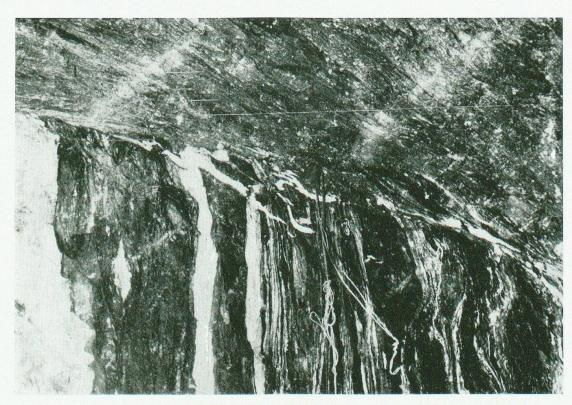
Photo 10. Diskordanter Lamprophyrgang in Nord-Süd-gebänderten Gneisen (Norden = oben). Zuleitungsstollen, unterer Teil, m 467 (First).
