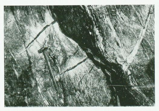
Photo 16. Flachliegende Zerrisse mit Chloritfüllung. Deutlich ist ein Bleichsaum ausgebildet. Die Risse treten in einem Gneispaket auf, das beidseitig von alpinen Bewegungsbahnen (primär sehr glimmerreichen Lagen) begrenzt wird. Zuleitungsstollen, unterer Teil, m 695.
