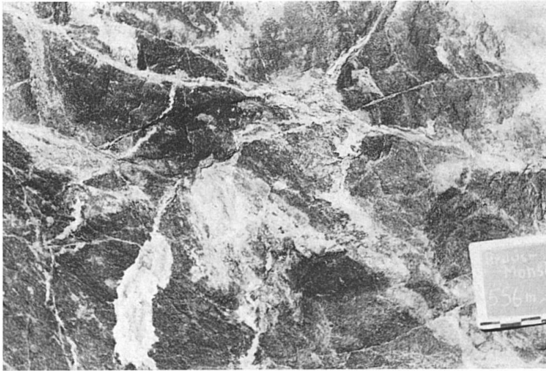
Fig. 6. Mit Gips gefüllte Klüfte. 556 m ab Stollenportal Ardüs.
