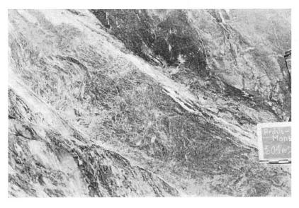
Fig. 8. Alpiner Mylonit in den Tuffen, auf der Oberseite starke, auf der Unterseite schwache Gipsausscheidungen. 601 m ab Stollenportal Ardüs.
