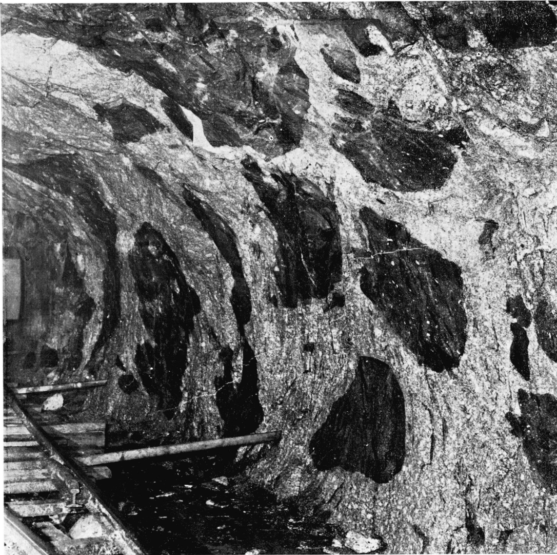
Fig. 5. Biotitreiche Schollen im Granodiorit, Albignastollen, Meter 3625. Eine derartige Scholle aus diesem Abschnitt (Meter 1067 ab Murtaira) ist in der Arbeit von WEIBEL (1960) analysiert. Die Zusammensetzung dieser Schollen ist quarzdioritisch. Im Vergleich zum umgebenden Granodiorit sind der Eisen-, Magnesium- und Calciumgehalt höher, während Kieselsäure und Kalium tiefer liegen. Stellenweise haben diese Schollen, die in ähnlicher Form im ganzen nördlichen Bergeller Massiv verbreitet sind, unscharfe Ränder. Im Stollen konnten alle Übergangsstadien von eingeschlossenen Gneisbrocken bis zu solchen dunklen, fast massigen Schollen beobachtet werden.
