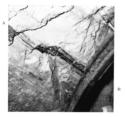
Fig. 2. Mit Pechblende vererzte Lage (A—B) im Stollen von Isérables. Helle Zwischenlagen im dunklen Band A—B = Rosaquarz.
