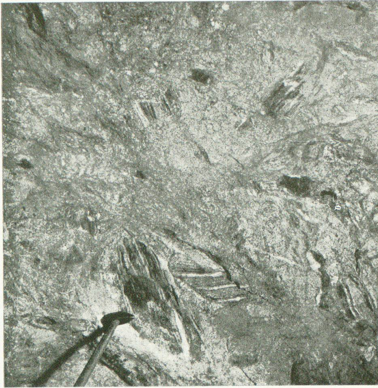
Abb. 3. Innertkirchnergranit, porphyrtartig, mit Amphibolitscholle (direkt ob Hammer) und verschiedenen Biotitgneisschollen (gebändert, meist scharf gegen Granit begrenzt). — Stollen Schaftelen nach Steinwasser, m 1025 („Bahnhof“, Talseite).
