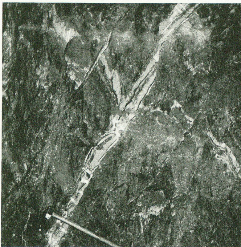
Abb. 2. Turmalin-Aplitgänge (von rechts oben nach links unten verlaufend) in Biotitschiefer des Altkristallins, ältere Quarzadern (hell) durchsetzend. — Stollen Rotlaur nach Trift, m 790 (talseitiger Stoss).
