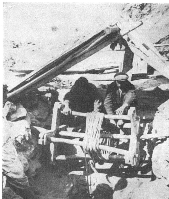
Figure 3. Mine d'orpiment de Zarehshouran, dans l'Afshar. Dispositif servant à l'extraction du minerai de 30 à 40 m de profondeur. Photo LADAME.
