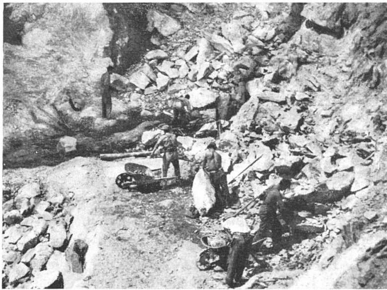
Fig. 5. Gewinnungsarbeiten in der Asbestgrube II.
