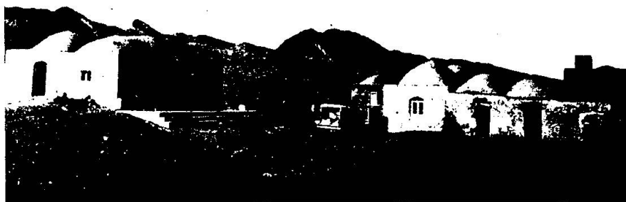
Figure no. 1. Vue Ouest-Est du chantier „Bozorgue“ mettant en évidence la structure en écaïlles de la région provoquée par une poussée Sud-Nord
