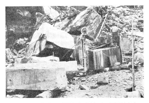
Fig. 2. Zersägen der Serpentinblöcke im Steinbruch mit Stahldrahtsägen.
