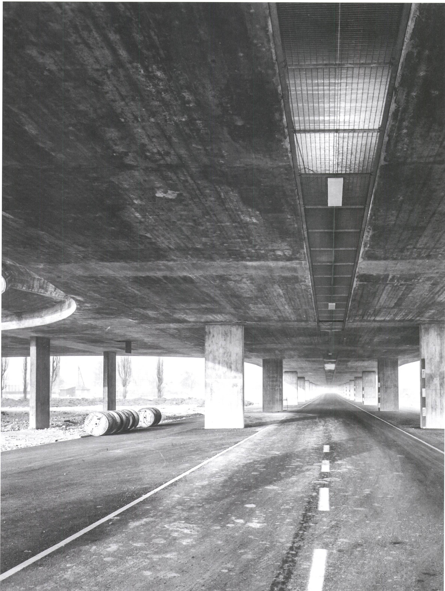
Die 1,1 Kilometer lange Europabrücke in Zürich wurde 1961/62 gebaut. Ihre Lebensdauer, wie die aller Brücken, beträgt 50 bis 100 Jahre. Laufende Investitionen können ihre Nutzung aber erheblich verlängern. Bild: Baugeschichtliches Archiv / Wolf-Bender Heinrich & Wolf-Benders Erben / CC BY-SA 4.0.
