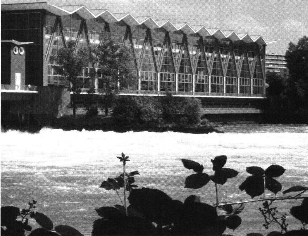
In Birsfelden. Denn seit kurzem wird das Kühlwasser aus dem Flusskraftwerk Birsfelden einer Alternativ-Energieanlage zugeführt. Mit der dadurch nutzbar gemachten Abwärme werden 1200 Wohnungen geheizt und jährlich 2300 t Heizöl eingespart. Das freut uns besonders, weil Sulzer an der Entwicklung der Wärmeversorgungsanlage massgeblich beteiligt war und die Sulzer-Filiale Basel für Planung und Ausführung verantwortlich zeichnete.
