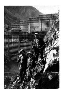
Bau der Staumauer der Grande Dixence im Wallis (1951-1962). Geologische Messungen hinter der emporwachsenden Staumauer. Photo: Frank Gygli
