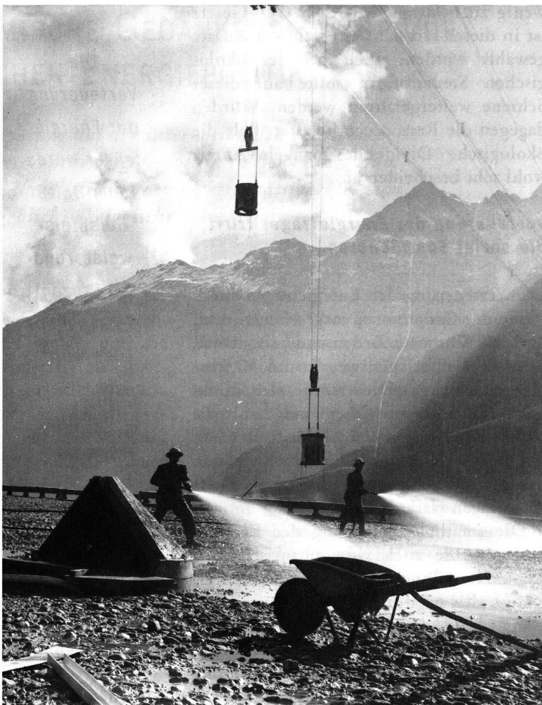
Betonierungsarbeiten an der Blava (Betonzentrale für die ganze Baustelle). Photo: Frank Gygli
