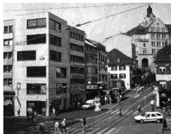
Büro- und Geschäftshaus am Barfusserplatz in Basel, 1993–1995 Architekten: Diener & Diener, Basel
