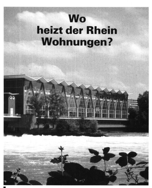
n Birsfelden. Denn seit kurzem wird das Kühlwasser aus dem Flusskraftwerk Birsfelden einer Alternativ-Energieanlage zugeführt. Mit der dadurch nutzbar gemachten Abwärme werden 1200 Wohnungen geheizt und jährlich 2300 t Heizöl eingespart. Das freut uns besonders, weil Sulzer an der Entwicklung der Wärmeversorgungsanlage massgeblich beteiligt war und die Sulzer-Filiale Basel für Planung und Ausführung verantwortlich zeichnete.
