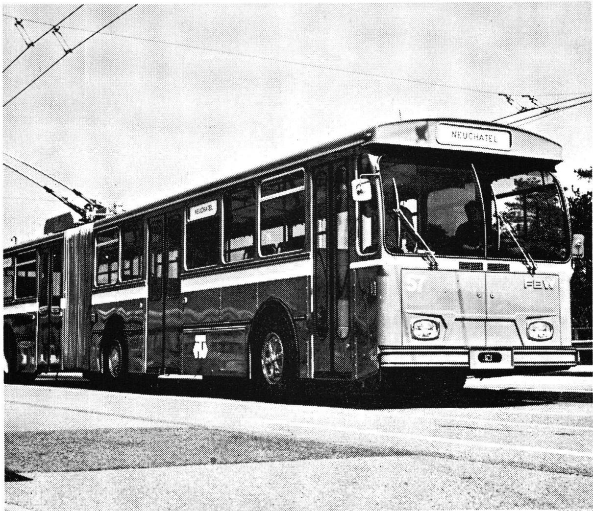
Fortschrittliche Geräte und Ausrüstungen von BBC helfen, diese wertvolle Energie sparsam zu gebrauchen: Zum Beispiel der Chopper bei Bahnen und Trolleybussen. Er regelt nahezu verlustfrei die dem Traktionsmotor zugeführte Energiemenge entsprechend dem jeweiligen Bedarf.
