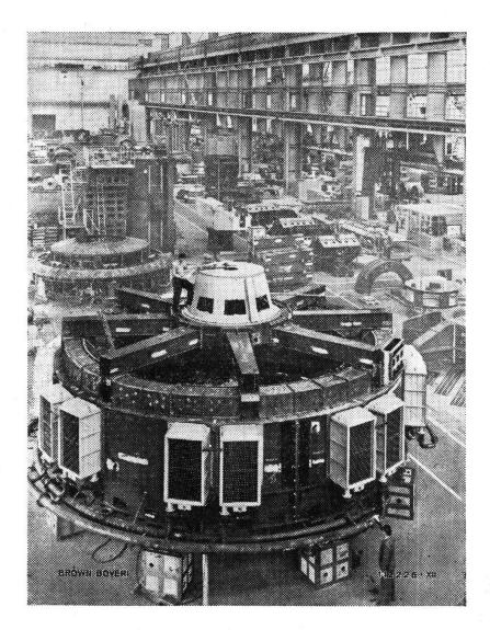
Stator eines der drei 60-MVA-Wasserkraftgeneratoren, 13800 V, 60 Hz, 106 U/min, für die Zentrale Wilson Dam der Tennessee Valley Authority, Knoxville (USA)
