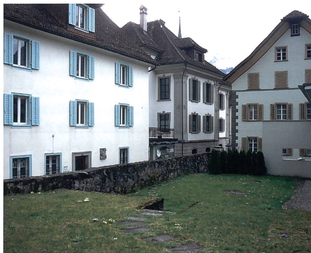
Abb. 4: Blick gegen das Zieri-Haus. Etwa in der Gartenmitte, vor den Stufen zum oberen Ziergarten, stand links an der Mauer die «Münz». Bei der Erhöhung des Niveaus zum oberen Gartenteil kamen an der Mauer verkohlte Balken zum Vorschein, Überreste der 1799 abgebrannten Münzstätte Altdorf.
