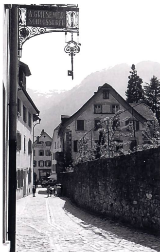
Abb. 3: Der Kapuzinerweg mit dem Zieri-Haus um 1946. Im Gartenareal, hinter der für Altdorf typischen hohen Gassenmauer, stand die «Münz». Links die Schlosserei Griesemer.
