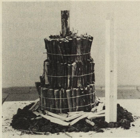
Meiler vor dem Auftragen der Lösche
