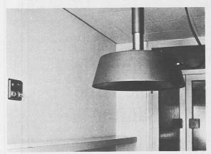
Typ SPH 10, 25 kW, höhenverstellbar mit 15 Luftaustrittsöffnungen
