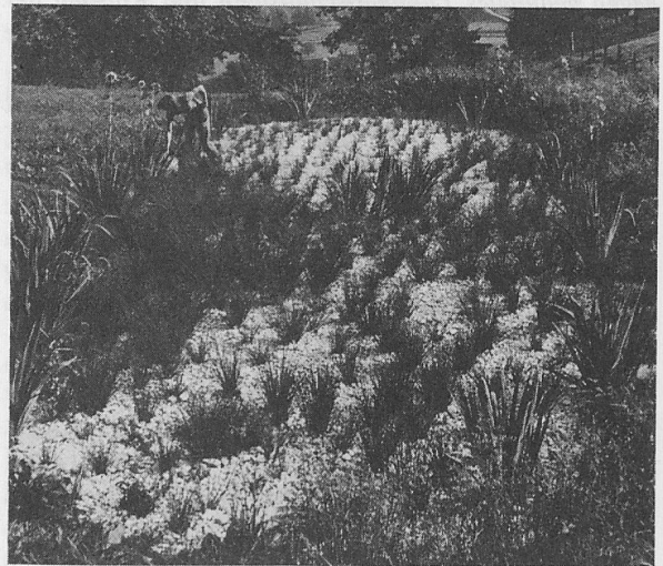
Limnoökologische («grüne») Kläranlage: nach der Klärgrube (Feststoffe) mit Binsen und Iris bepflanzt. Feinschotterbett
