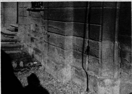
Ursache: Kapillar aufsteigende Mauerfeuchtigkeit. Typische Folgeschäden an Putz und Naturstein.
