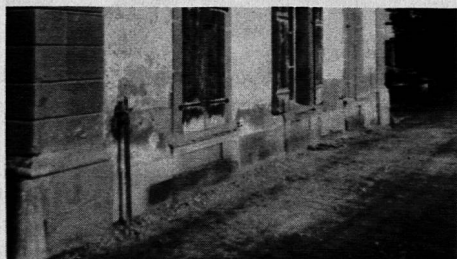
Ursache: Kapillar aufsteigende Mauerfeuchtigkeit. Typische Folgeschäden an Putz und Naturstein.
