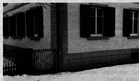
Beispiel einer Elektroosmose-Fassadenentfeuchtung. Obere Aufnahme: Mauerentfeuchtung und Ausblühungsschutz sind ausgeführt, die Austrocknung macht rasche Fortschritte. Das untere Bild zeigt den Zustand fünf Jahre später.
