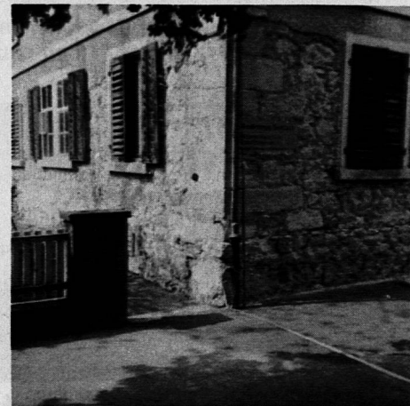
Beispiel einer Elektroosmose-Fassadenentfeuchtung. Obere Aufnahme: Mauerentfeuchtung und Ausblühungsschutz sind ausgeführt, die Austrocknung macht rasche Fortschritte. Das untere Bild zeigt den Zustand fünf Jahre später.
