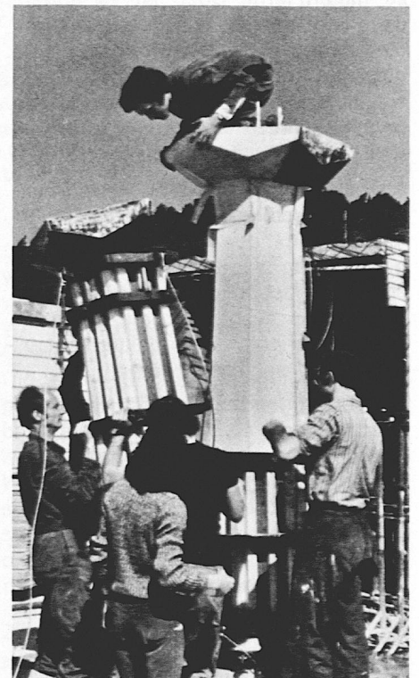
Werkgruppe beim Ausschalen einer Säule. Das ganze Schulgebäude ist Werk intensiver Mit- und Zusammenarbeit vieler!
