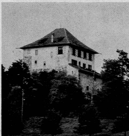
Mörsburg ZH – Mauerdicke 4,5 bis 5 m
