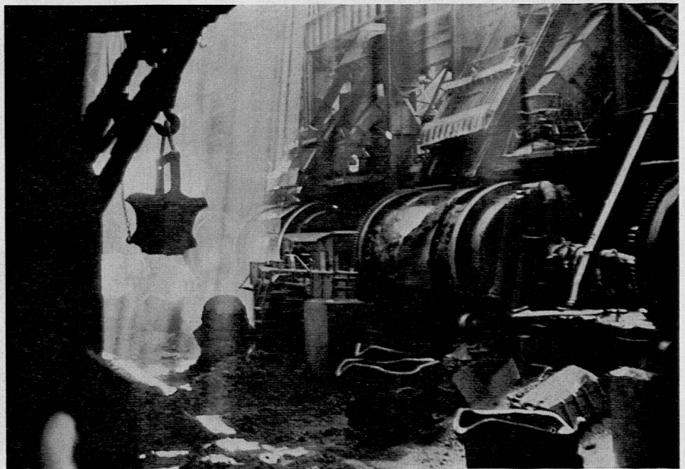
Im Schmelzwerk: Im Konverterofen wird der Schwefel verflüchtigt und das Eisen verschlackt, um vom Kupfer getrennt zu werden.
