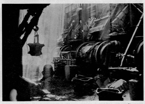
Im Schmelzwerk: Im Konverterofen wird der Schwefel verflüchtigt und das Eisen verschlackt, um vom Kupfer getrennt zu werden.
