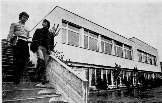
Die UMA-Anlage ist auf dem Lehrschwimmbecken errichtet
