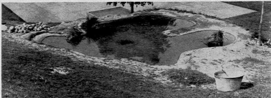
Auffüllen und erste Bepflanzung. Seggen- und Schilfstöcke lassen sich mit viel natürlichem Bodengrund direkt auf den Beton stellen. Mit den beim Aushub aufgesparten Rasenziegeln lässt sich die Umgebung verkleiden.
