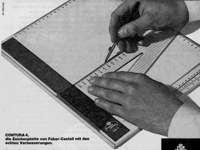
Starke Spannschiene aus Stahl mit neuartiger Klemmvorrichtung.
