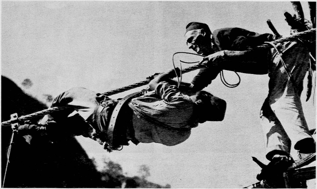
Chefmonteur Alois Lütolf aus Luzern und ein nepalischer Vorarbeiter beim Montieren einer Hängebrücke über den Marsyandi-River bei Sattale.
