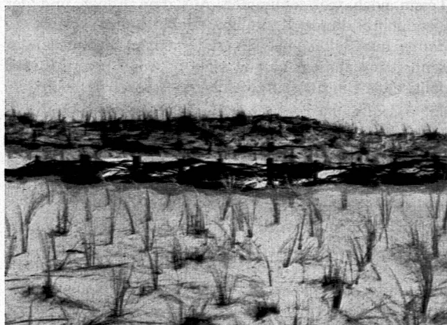
Dünen mit Faschinen (Holzpfähle mit Geflecht aus Aesten) und Strandhafer.
