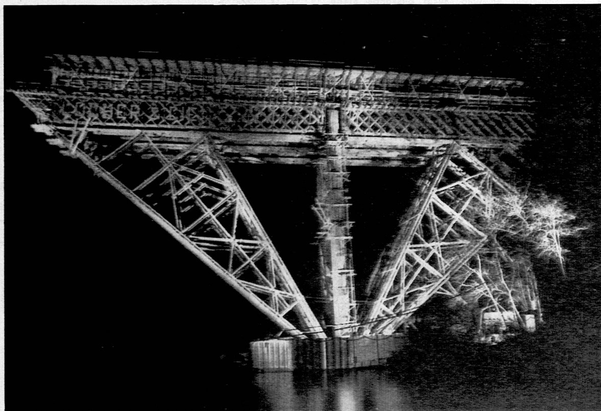
Lehrgerüst der Weinlandbrücke bei Andelfingen im Kanton Zürich
