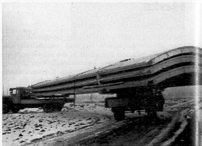
Transport rostförmig verleimter Sheddach-Elemente Projektierung Dr. Ing. E. Staudacher, Zürich
