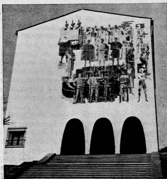
Fassade des Archivs von Schwyz.
