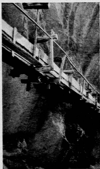
Bisse von Savièse. Kanal und Fußsteg hängen in der Luft. Die Leitung ist undicht, sie tropft.
