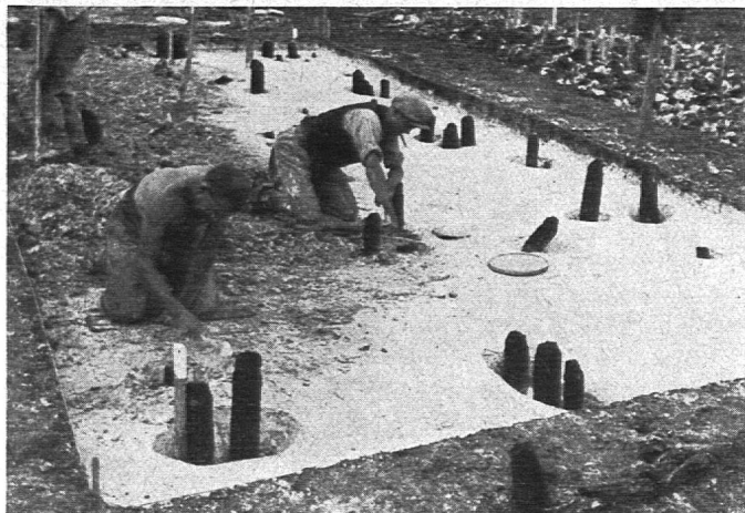
Beim Freilegen der Hauspfähle.
