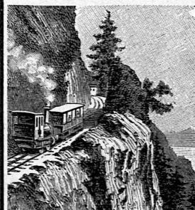
Kräbelwand Partie der Arth-Rigi-Bahn
